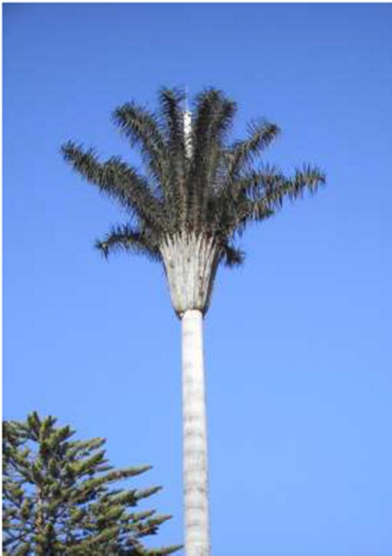
Als Palme geschickt getarnter Handymast im Stadtzentrum von Swakopmund / Namibia (die Palme ist aus Plastik und Stahl)
